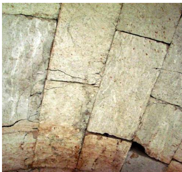
Εικ. 26. Μικρο και μακρο - ρηγματώσεις θόλων κυρίου θαλάμου τάφου Γ'.
