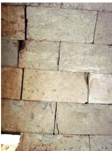
Εικ. 26. Μικρο και μακρο - ρηγματώσεις θόλων κυρίου θαλάμου τάφου Γ'.
