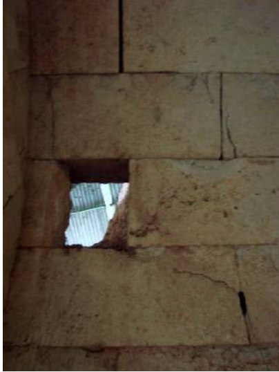
Εικ. 23. Απαλείψεις πέτρινων στοιχείων από την θολωτή σκεπή του τάφου.
