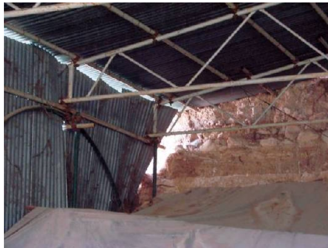
Εικ. 32. Πέλλα. Προσωρινό μεταλλικό στέγαστρο τάφου Δ'.
